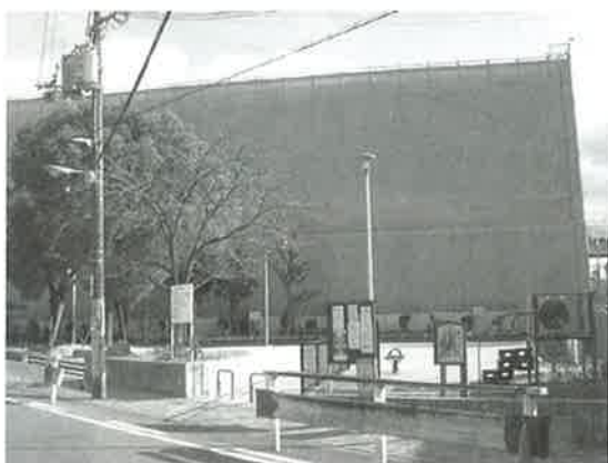
▲リュミエール加島の工事も順調に進んでいる（1月初旬撮影）
